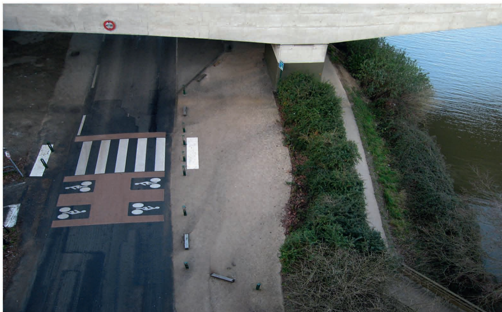
[ Marquages au sol sur la berge sous les ponts de la Jonnelière ]
